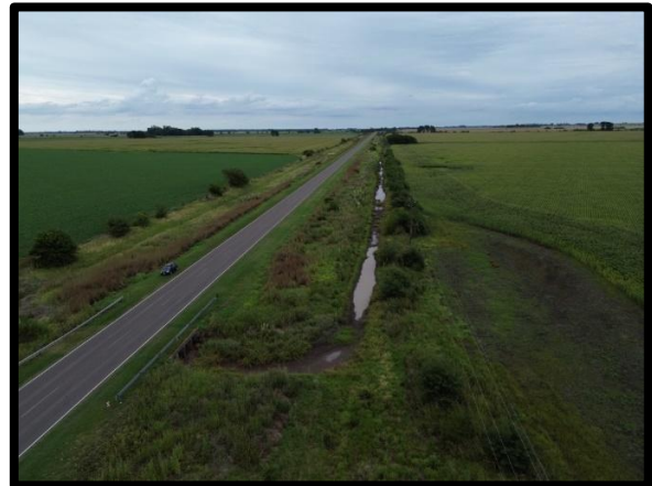
Figura 54 – Intersección del Canal de Mihura con la traza de la RPNº11. Se observa el puente existente.
