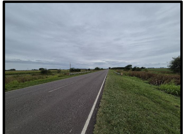
Figura 50 – Intersección del Canal de Mihura con la traza de la RPN o 11. Se observa el puente existente.
