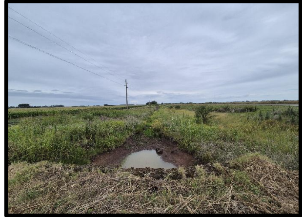
Figura 48 – Intersección del Canal de Mihura y punto de acceso a propiedad privada, vista canal hacia sudeste.
