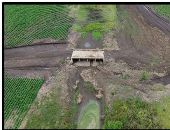
Figura 58 – Canal de Mihura, vista hacia sudoeste, vista estructura de alcantarilla.
