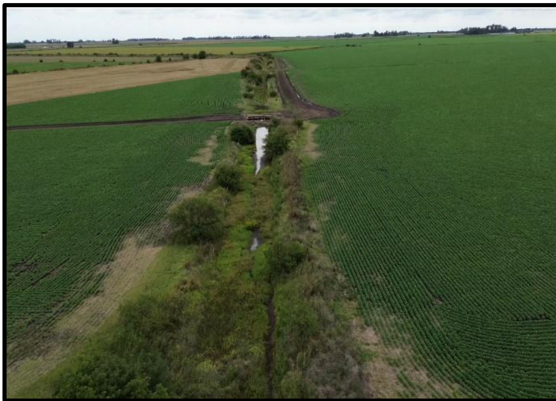
Figura 56 – Canal de Mihura, vista hacia sudoeste.
