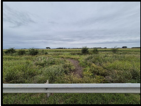
Figura 51 – Intersección del Canal de Mihura con la traza de la RPNº11, vista hacia noreste.
