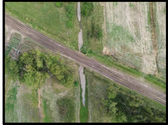
Figura 62 – Intersección Canal de Mihura y Camino del Consorcio.
